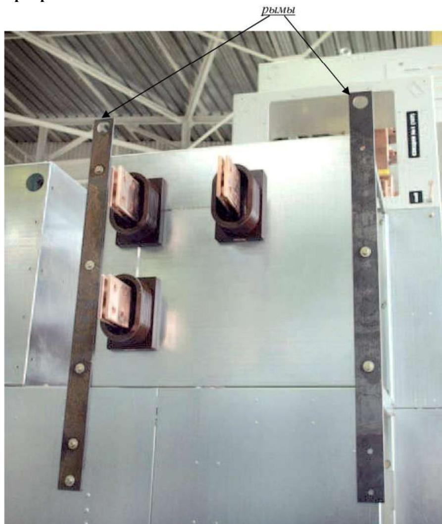
Рисунок 16 – Рым пластины для транспортировки шкафа
