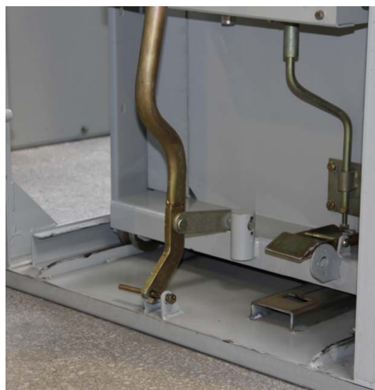
Рисунок 5 Рабочее положение тележки
