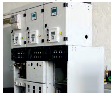
КРУ В ТВЕРДОЙ ИЗОЛЯЦИИ до 1250А
