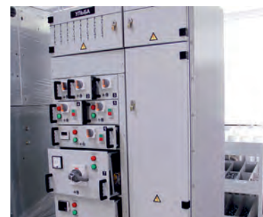
НКУ 0,4кВ на основе модульной сетки
