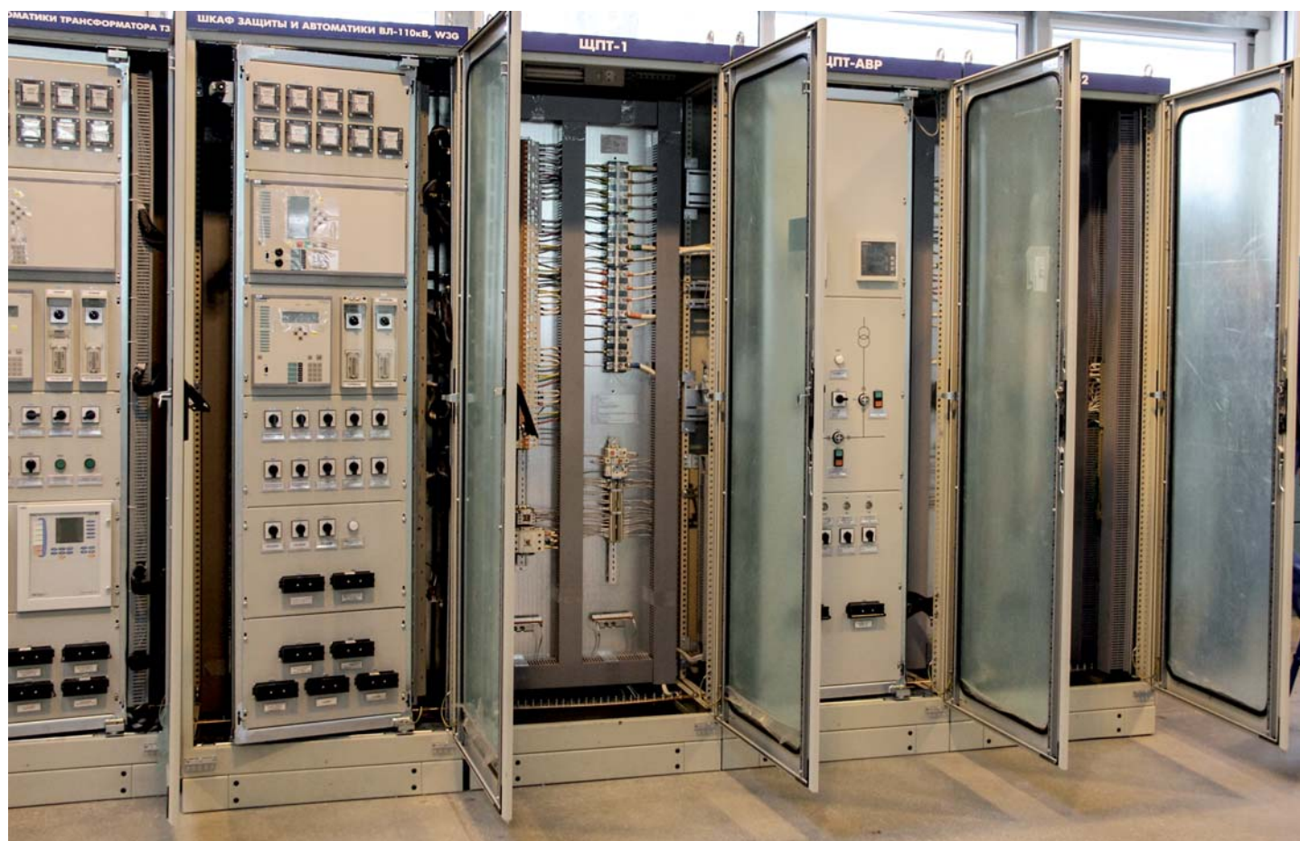
ШКАФЫ РЕЛЕЙНОЙ ЗАЩИТЫ И АВТОМАТИКИ типа ШРЗА-КЕМ/kz
