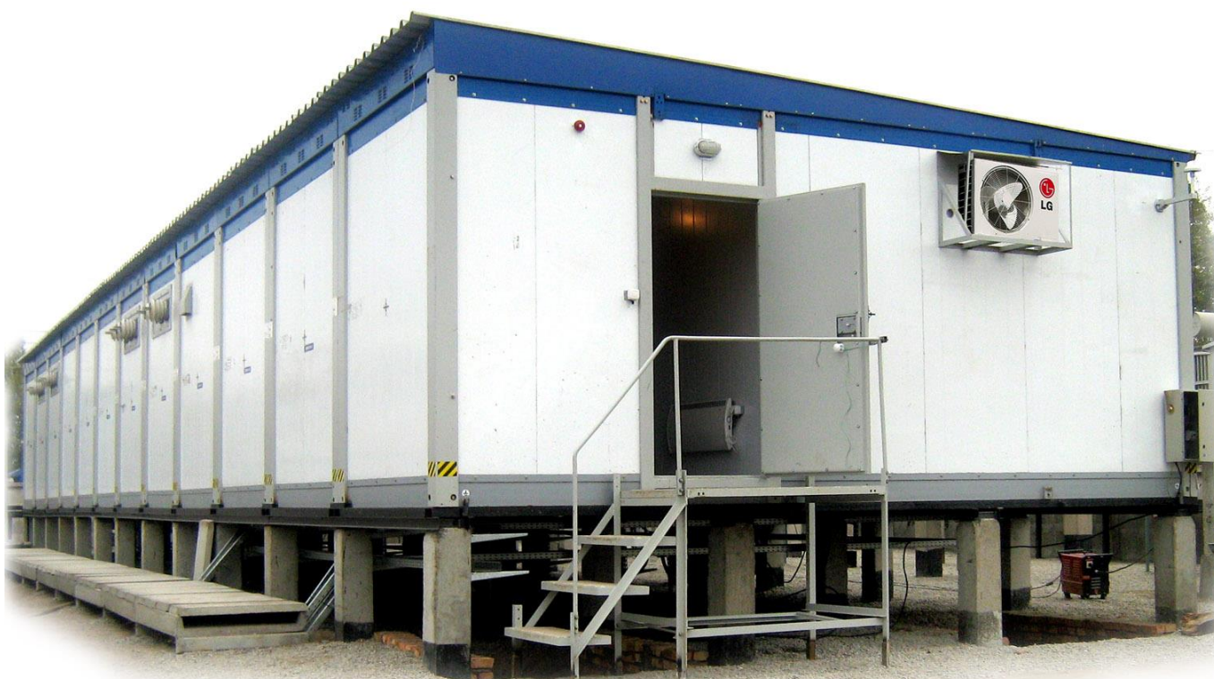
б) Здание на фундаменте
