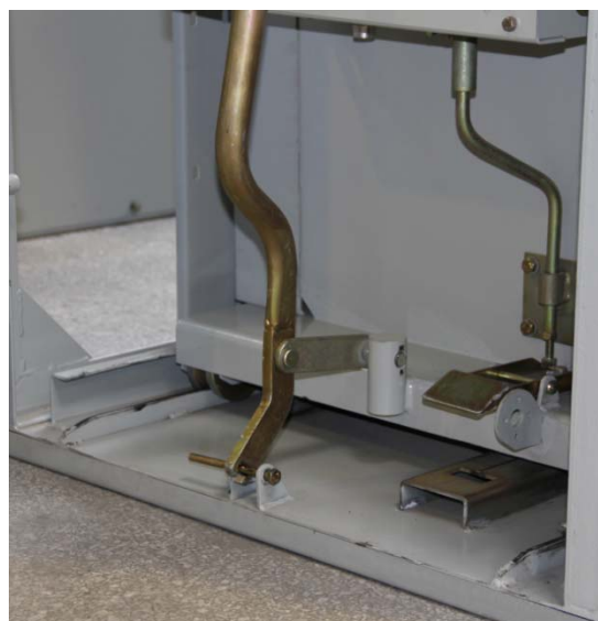
Рисунок 8 Рычаг вката-выката
